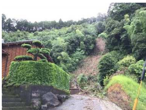
本城地区(鹿児島市本城町) がけ崩れ災害 (死者1名)
