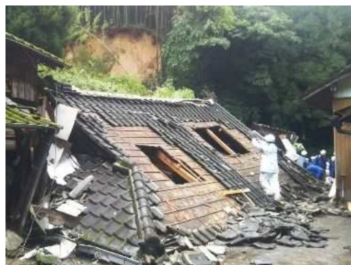
坂元地区(曽於市大隅町) がけ崩れ災害 (死者1名)
