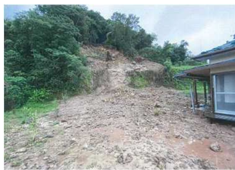
出水市高尾野町江内 がけ崩れ災害
