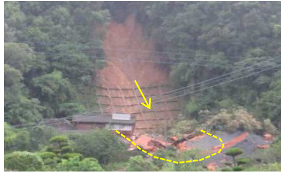
北上1地区(始良市蒲生町)がけ崩れ災害 (死者1名)
