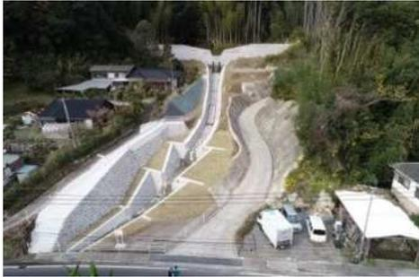
砂防堰堤により、火山地域の荒廃地の異常な土砂流出による災害から、下流の人家等を保全しています。
