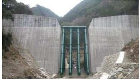
砂防堰堤により、火山地域の荒廃地の異常な土砂流出による災害から、下流の人家や避難路等を保全しています。
