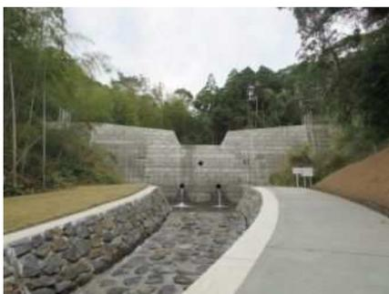
砂防堰堤及び溪流保全工により、直下流の人家及び避難路（県道7号、町道）等を土石流から保全しています。
