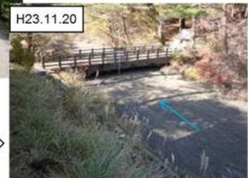
新燃岳の下流にある霧島川では、平成23年の噴火後に整備をした第10号砂防堰堤が、出水期の降雨で流出した土砂(降灰等)を捕捉することが出来ました。
