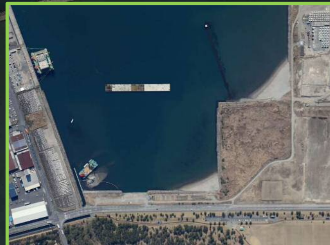
幹線貨物輸送拠点 (耐震強化岸壁整備中)
