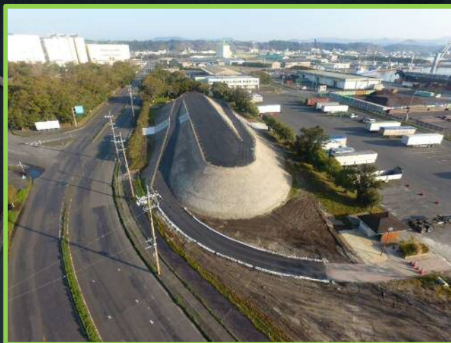
津波避難高台整備中 (令和6年度完成予定)
