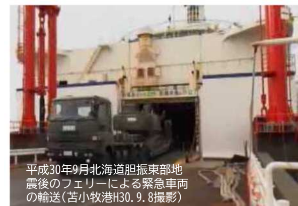
フェリー・ROROターミナルの耐震化
