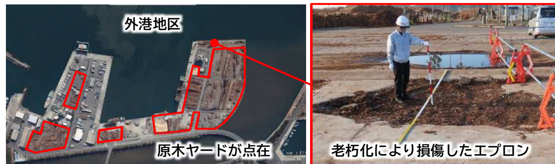
老朽化や利用状況等に応じた施設の利用転換
