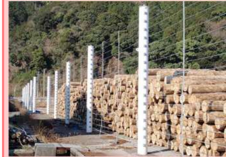
流出防護柵の設置
