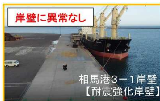
耐震強化岸壁整備による災害時の効果事例 (令和3年福島県沖を震源とする震度6強の地震)
