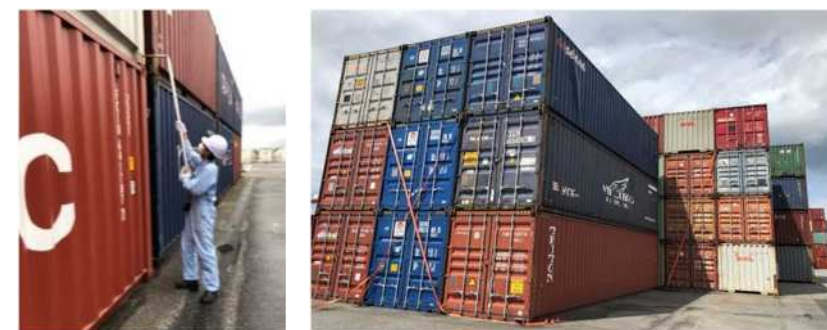
固縛器具やラッシングベルトによるコンテナの流出防止対策
