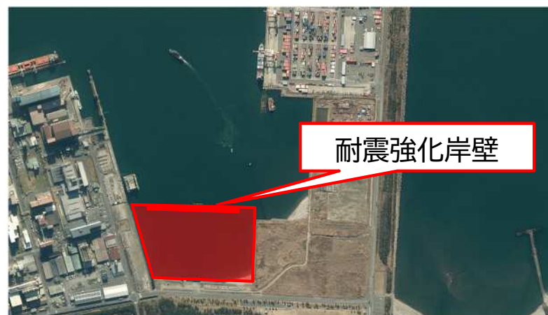
バルク岸壁（耐震強化岸壁）の整備
