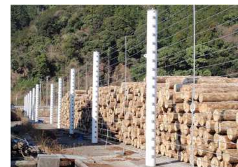
原木流出防止柵の事例
