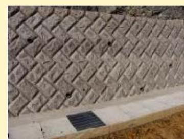
擁壁には、水抜き穴（一般には直径75mmのパイプ）が、擁壁の前面に設置されています。これが不足していると擁壁の背後で水が溜まり水圧がかかり、擁壁が危険な状態になるからです。水抜き穴の点検方法は、水抜き穴のぞき「ゴミが詰まって水の流れを阻害していないか。」、「土が流れ出ていないか。」等をチェックします。土が流れ出ている場合や、泥水が流れ出でている場合には、擁壁の裏側の土が不安定になっている場合があり、危険な状態である可能性があります。
