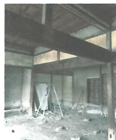
●空き家活用の再生は、「内部の計画解体」から始まる
