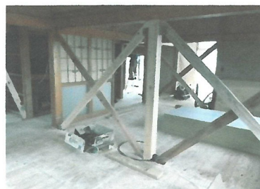
●古い構造体は、古民家再生に利用される A／「荒壁パネル」 B／「筋交い」で補強する
