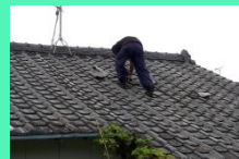
（瓦の取替え作業）
