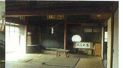
施工前床の間・書院
