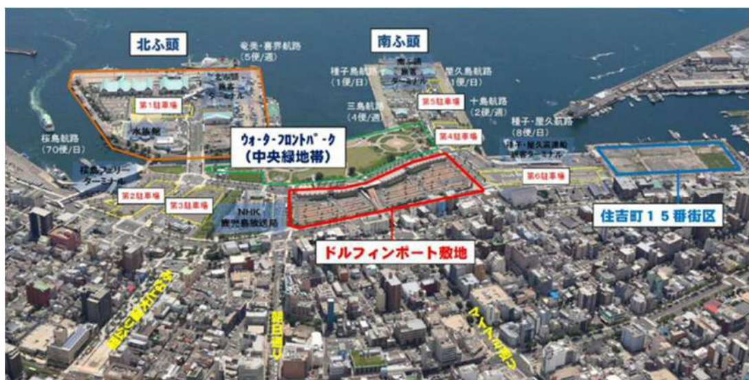
図表 4 - 1 鹿児島港本港区エリア全体の概況
