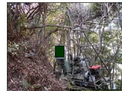
ボーリング調査
