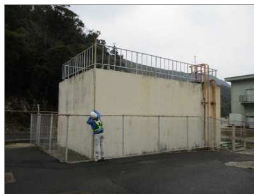
既設構造物調査
