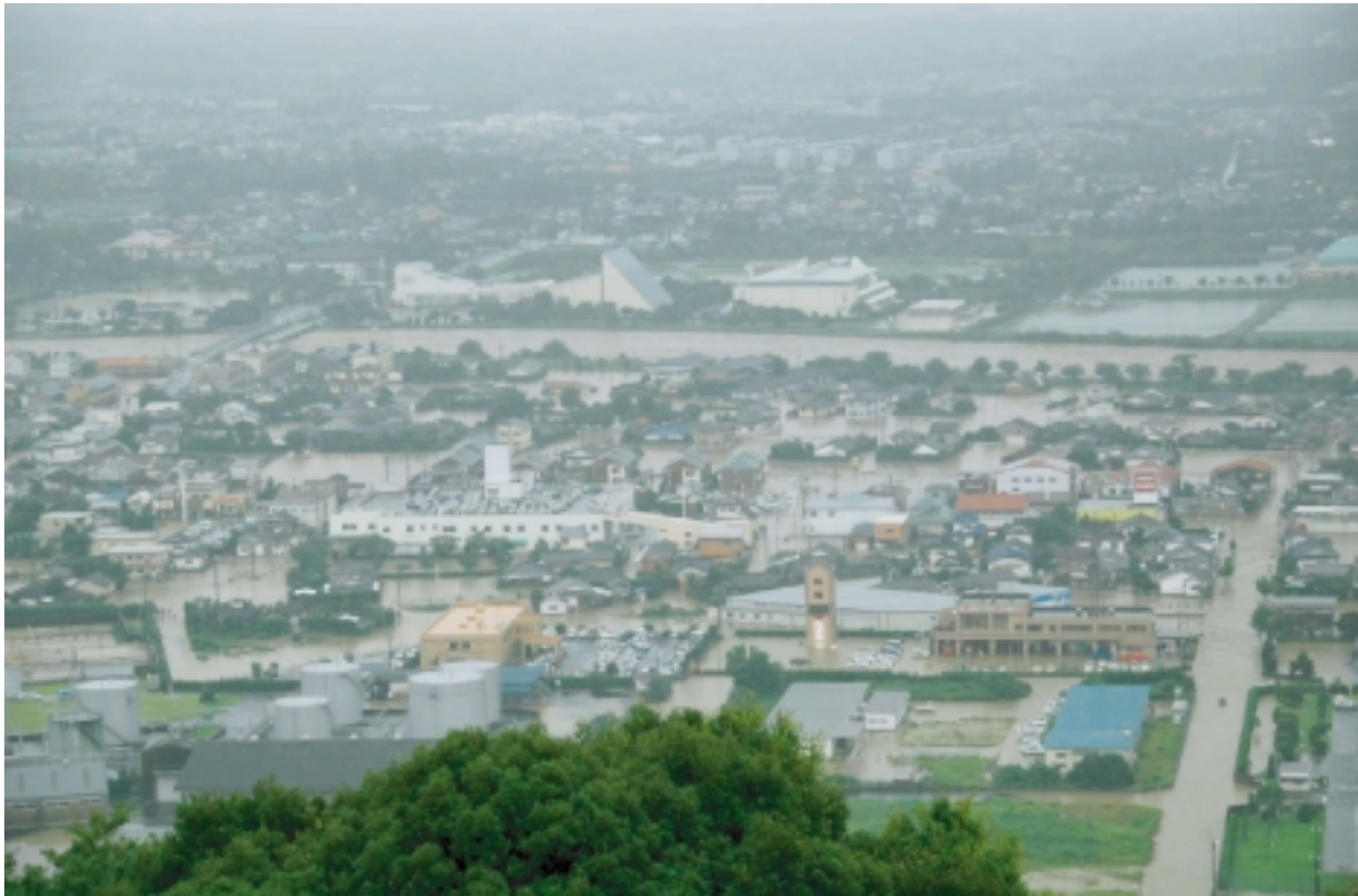
米之津川下流域（出水市 市街地）における浸水状況
