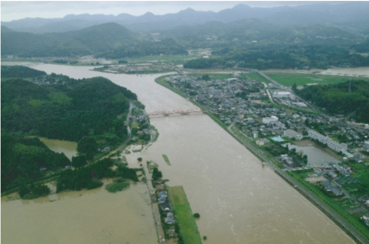
川内川下流域（薩摩川内市 東郷・久住地区）における浸水状況
