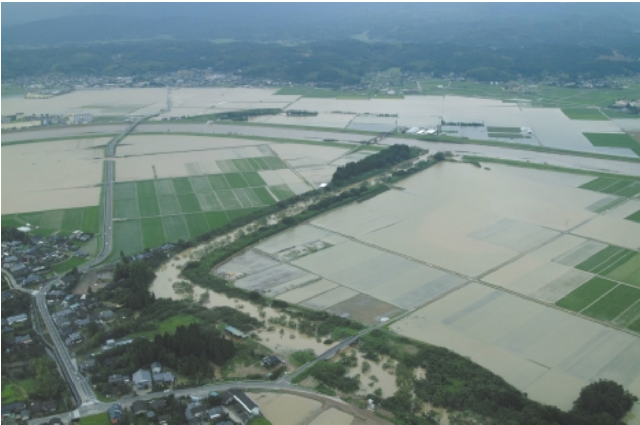
川内川中流域及び川間川（菱刈町 前目・本城地区）における浸水状況
