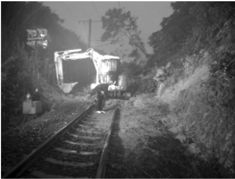
法面崩壊による途絶状況
