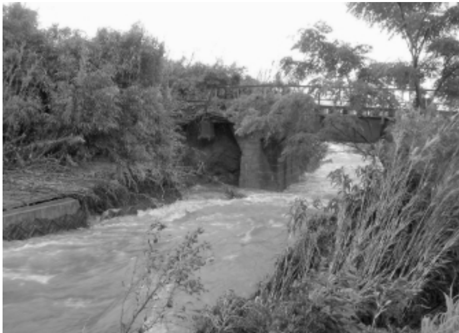
盛土の流出状況
