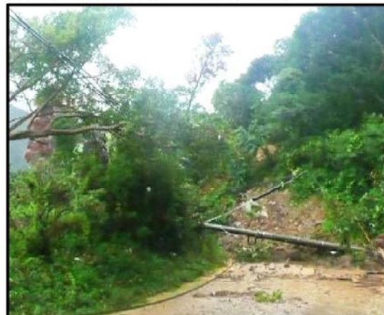
【奄美市住用町：崖崩れによる電柱倒壊】
