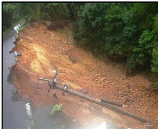
【瀬戸内町：崖崩れによる電柱倒壊】
