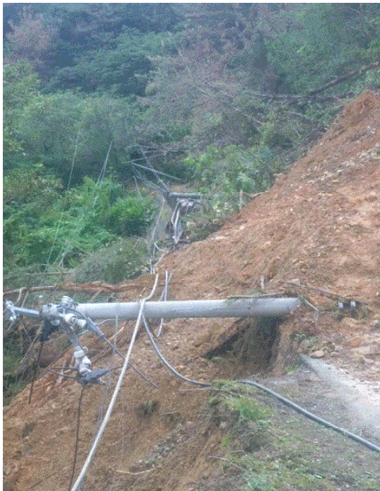
瀬戸内町嘉鉄地区，土砂崩れによる電柱倒壊，及びケーブル切断
