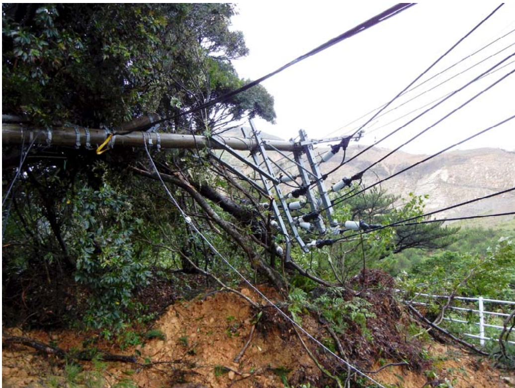
配電設備被害状況(瀬戸内町阿木名)
