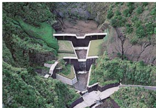
口絵17 土石流の被害を回避する砂防ダム
