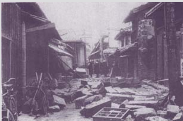
口絵10 地震による鹿児島市の被害(出典：桜島大正噴火誌)
