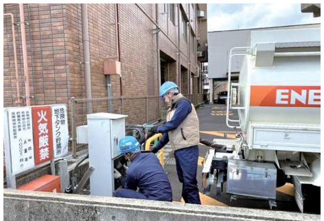
非常用発電機への燃料供給訓練
