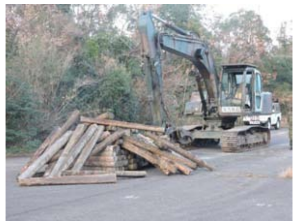
自衛隊による道路啓開
