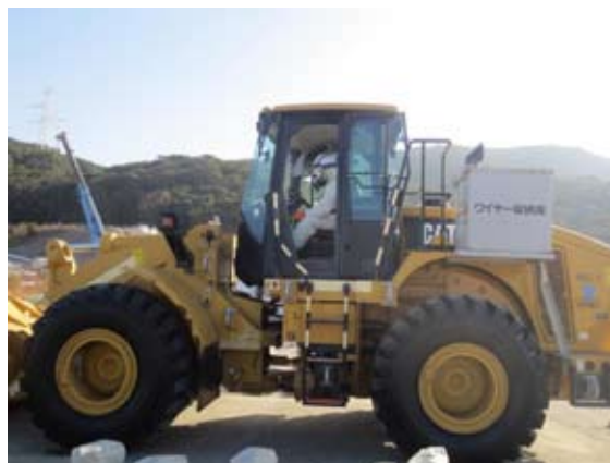
発電所内道路啓開
