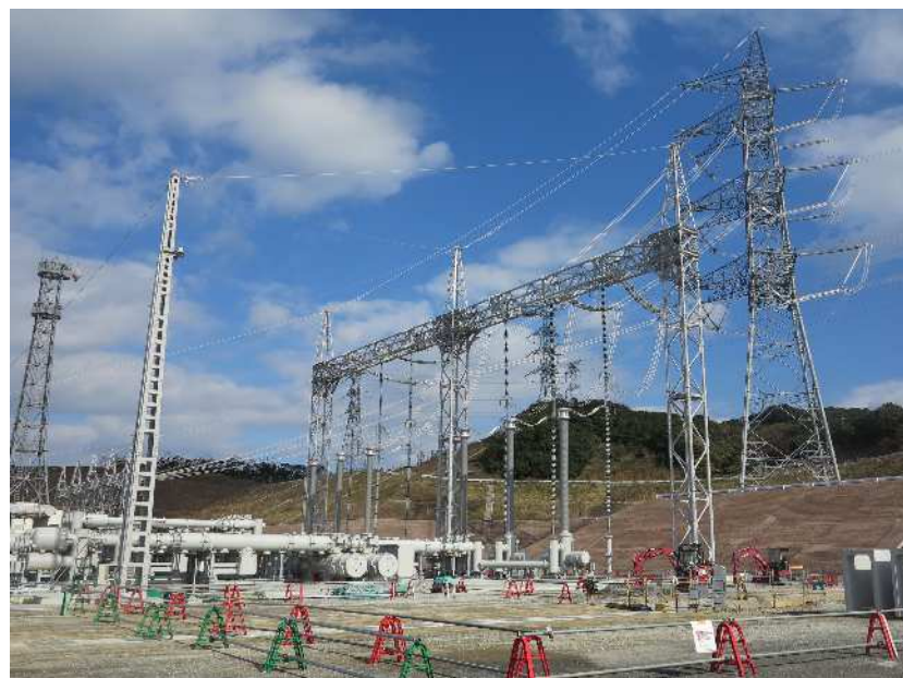
【500kV開閉所 工事状況(工事完了)】
