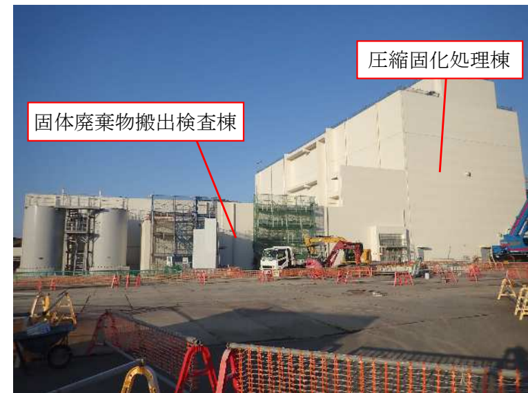
【廃棄物搬出設備 工事状況（建屋工事状況）】
