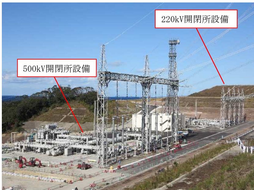
【特高開閉所 工事状況(全景)】
