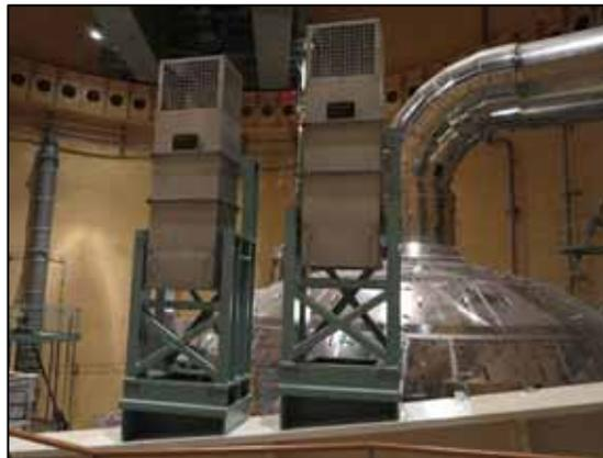
静的触媒式水素再結合装置
