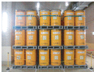
固体廃棄物貯蔵庫での保管状況
