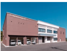
環境放射線監視センター
