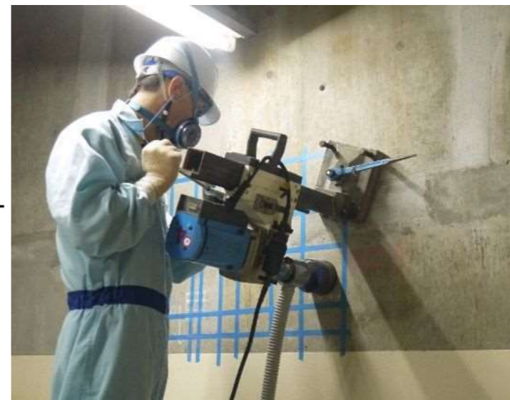
コンクリートサンプル採取状況
