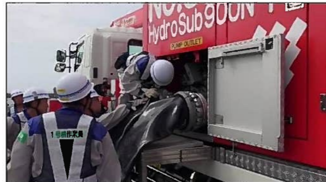
◇移動式大容量ポンプ車の設置
