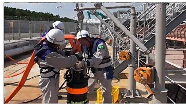
◇海水を取水するための水中ポンプ設置
