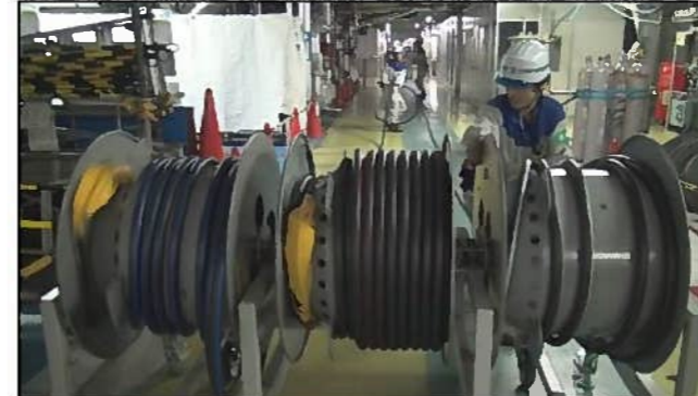
◇電源ケーブル布設(屋内)
