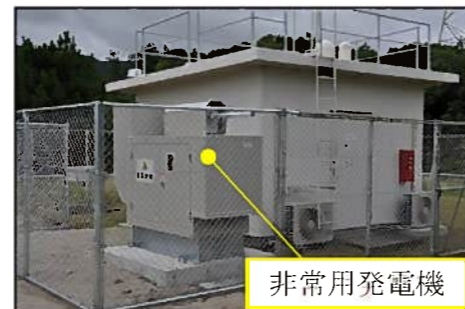
環境放射線測定装置の電源強化
