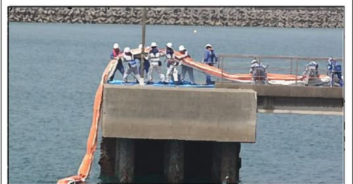
◇シルトフェンス(海中カーテン)の設置
