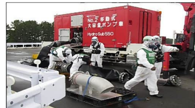
◇ホースの布設
