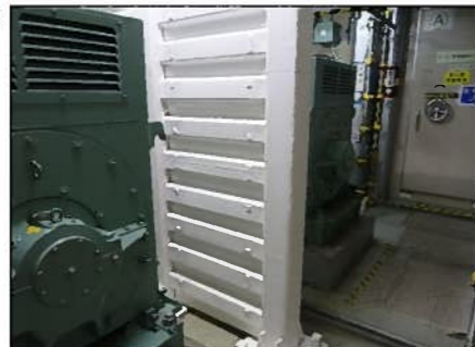
【耐火隔壁の設置】
