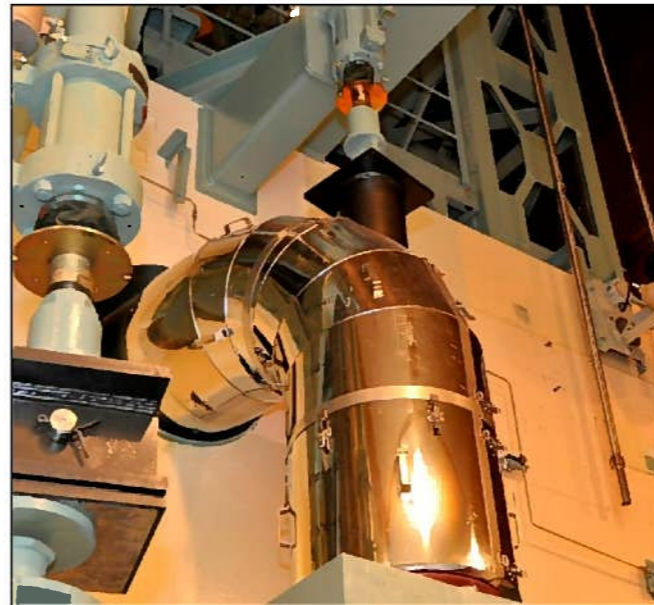
【配管のサポート補強】
