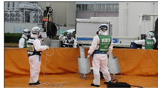
◇中間受槽(水槽)の設置
