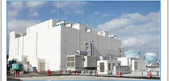
緊急時対策棟（指揮所）【外観】
