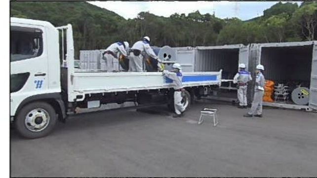
◇電源ケーブルの運搬
