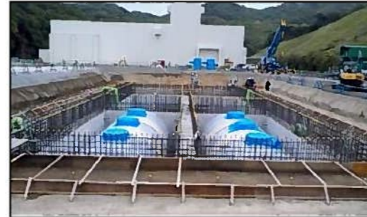
燃料油貯蔵タンク増設
