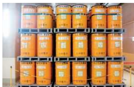
固体廃棄物貯蔵庫（内部）
