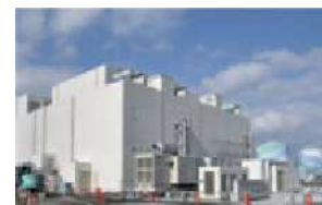
⑤緊急時対策棟(指揮所)外観
