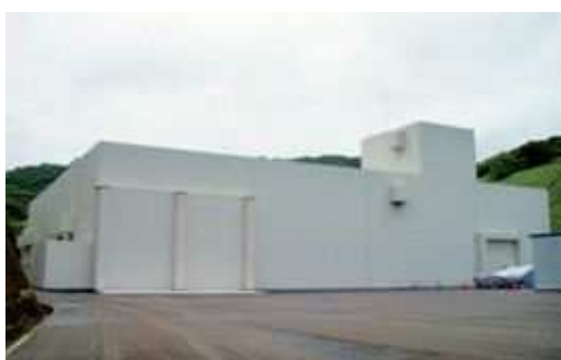
固体廃棄物貯蔵庫
