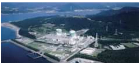
放水口、気象、排気筒4箇所、電気出力
