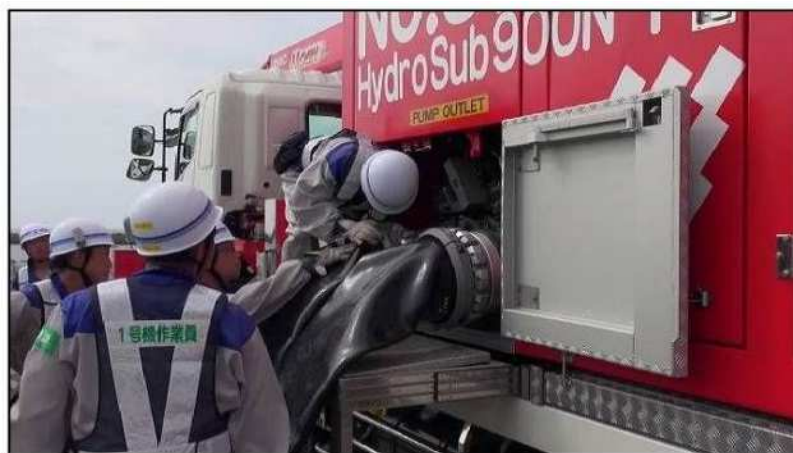
移動式大容量ポンプ車の設置
