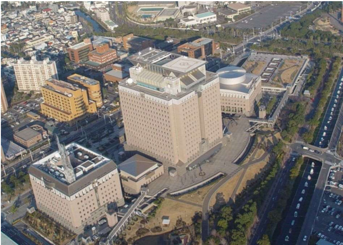
(5) 南東側上空から見た県庁屋上ヘリポート
