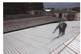
屋根の消石灰塗布
