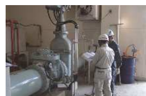
○機能診断（加圧ポンプ）
