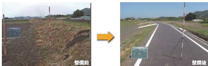
○中山間地域農業農村総合整備事業 日置南部地区（農道整備）
