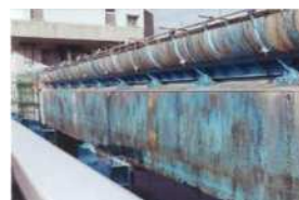
水門(ゲート塗装の劣化)
