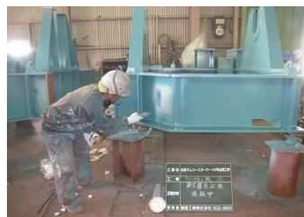
塗装による機械設備の補修
