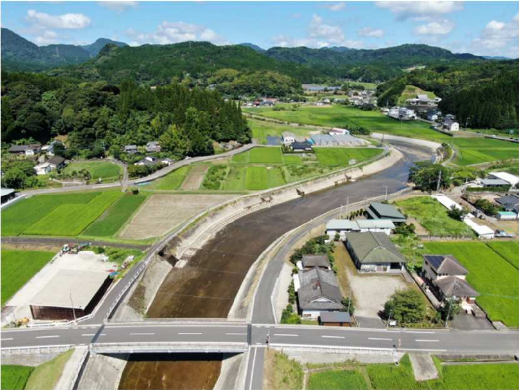
いちき串木野市 大里川（完成後）
