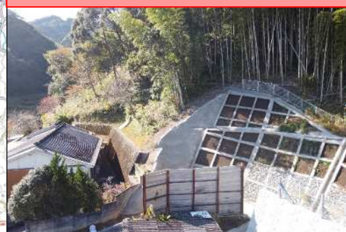
急傾斜地崩壊対策事業(鹿児島市・大中和地区)
