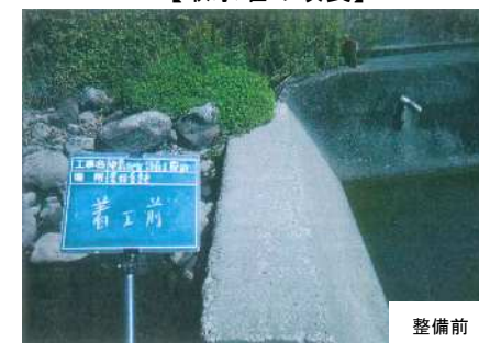
【取水堰の改良】
