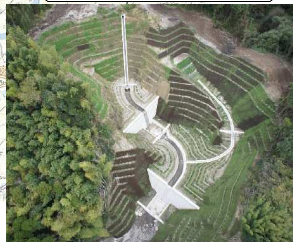
治山施設の整備（溪間工・山腹工）
