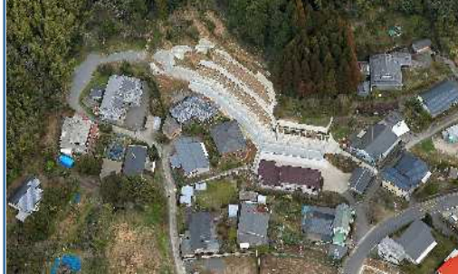
急傾斜地崩壊対策事業(日置市・久木元地区)
