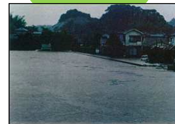
浸水被害(平成5年8月6日)
