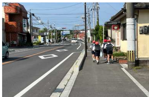
歩道の整備(万世工区)
