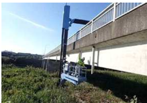
橋梁の点検状況 （万之瀬橋）
