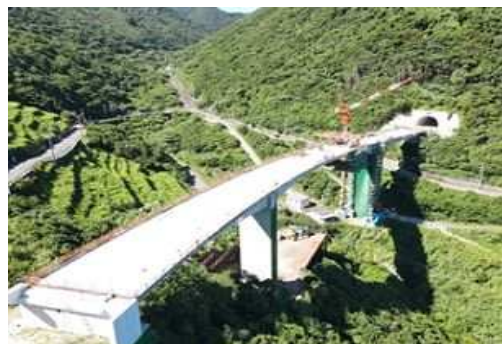
災害に強い道づくり （国道226号 笠沙道路）
