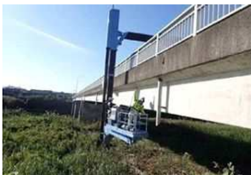
橋梁の点検状況 （万之瀬橋）
