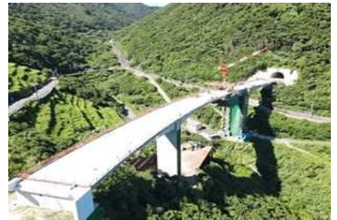
災害に強い道づくり (国道226号 笠沙道路)
