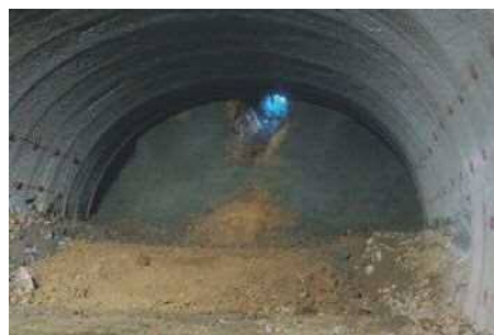
トンネル貫通の瞬間
