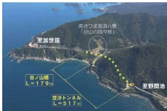
笠沙道路の概要【施工中区間】
