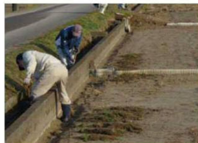
水路の土砂上げ状況
