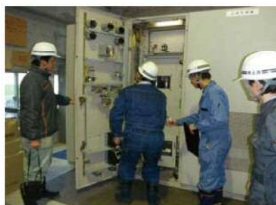
施設点検状況
