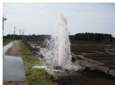
漏水事故発生状況
