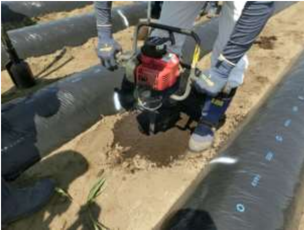
図6 穴掘り機による作業
