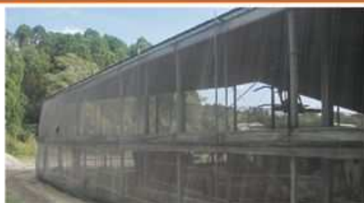
写真1 ネット設置状況
