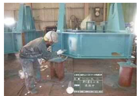
塗装による機械設備の補修
