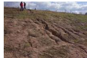
堤防(法面の浸食)
