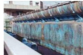
水門(ゲート塗装の劣化)
