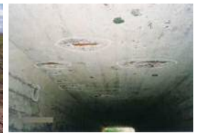
樋門・樋管(鉄筋の露出・腐食)
