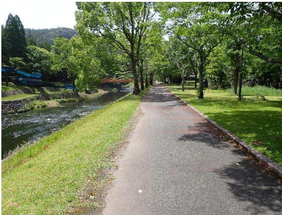
【透水性舗装を施工した道路写真】
