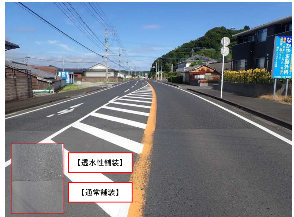
【透水性舗装を施工した道路写真】
