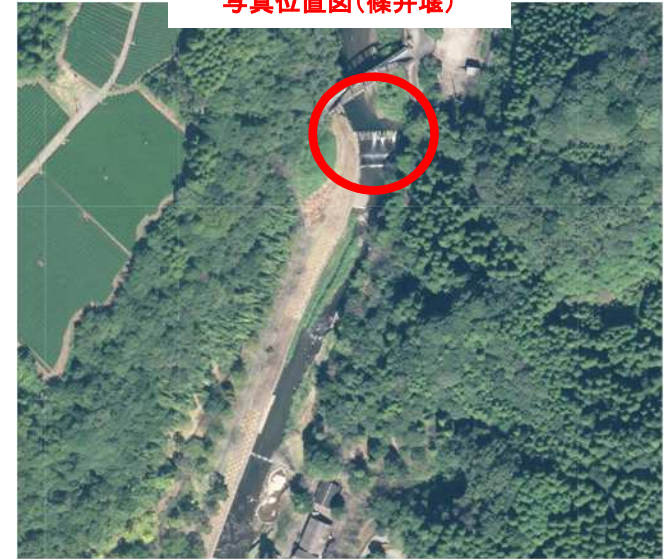
現況写真(篠井堰)
