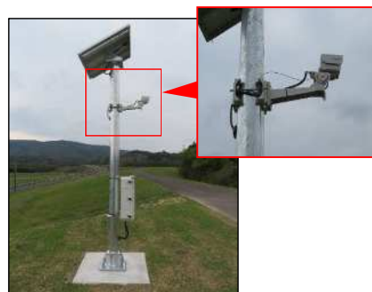
簡易型河川監視カメラ
