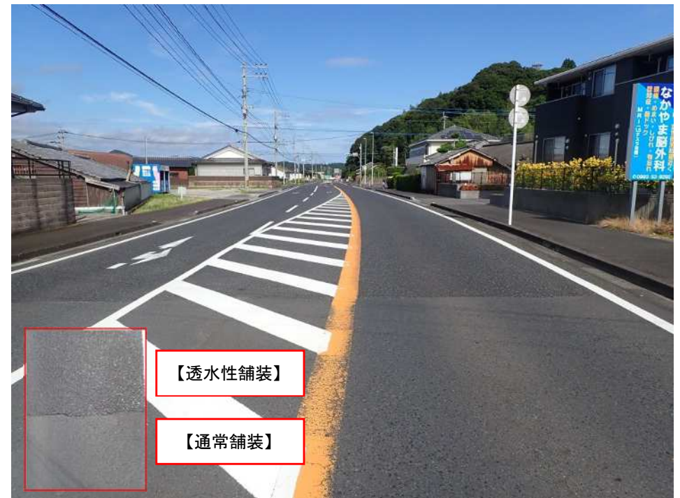
【透水性舗装を施工した道路写真】
