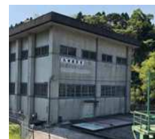
西部第2揚水機場
