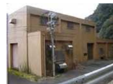
南部揚水機場
