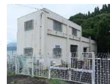
東部揚水機場
